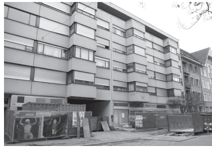
L'immeuble de la Vogesenstrasse 132 à Bâle, dont les locaux devraient être loués au nouveau centre de médecine reproductive de l'hôpital universitaire de Bâle. Illustration : biorespect
